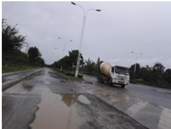
科技城达到铺设段
