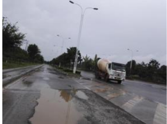
科技城达到铺设段
